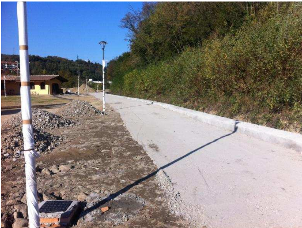
Figura 25 Strada pronta per l'asfaltatura
