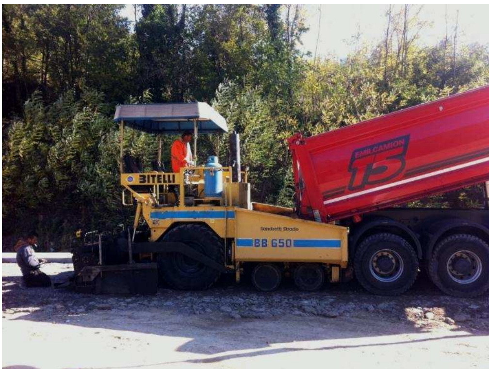
Figura 24 Livellamento dello stabilizzato prima dell'asfaltatura
