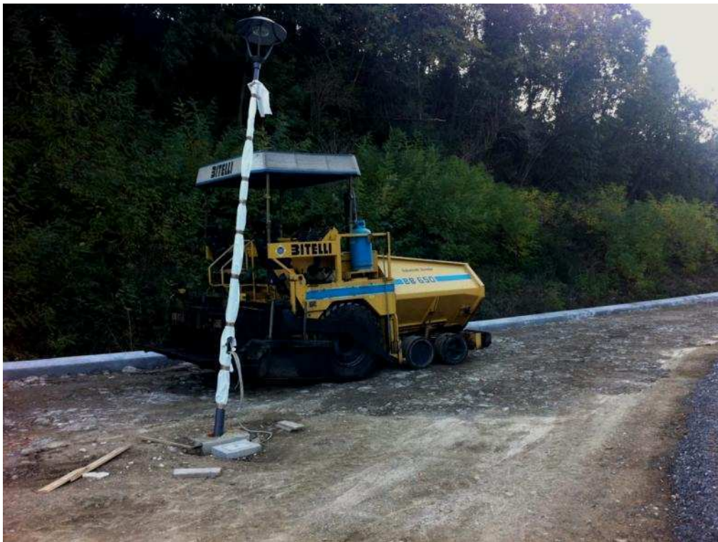
Figura 23 Finitrice in attesa di stendere lo stabilizzato
