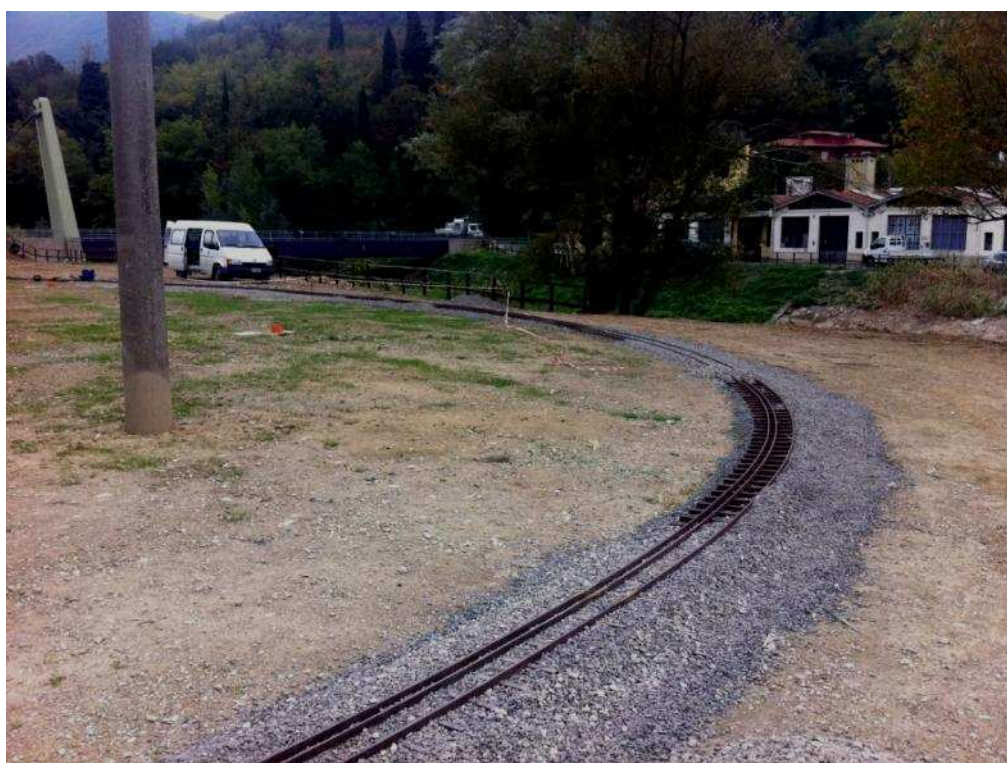
Figura 8 Curva lato Nord con parte dei binari ancora da inghiaiare
