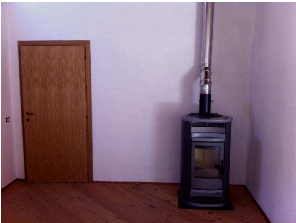
Figura 3 Stufa a legna a ventilazione forzata per riscaldare i due ambienti
