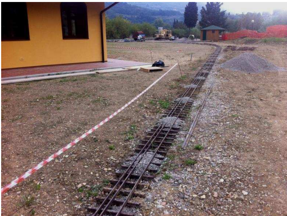
Figura 11 Binario in fase di livellamento
