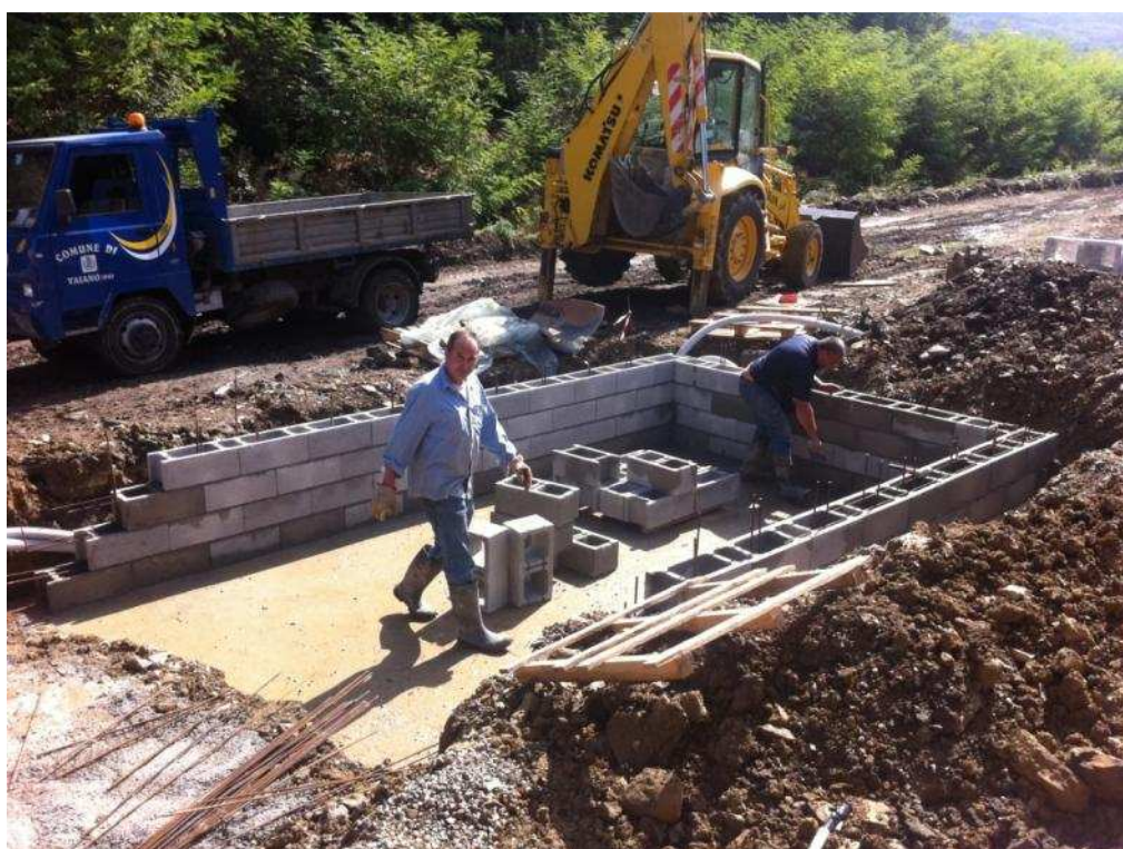
Figura 4 Vista della fossa di manutenzione
