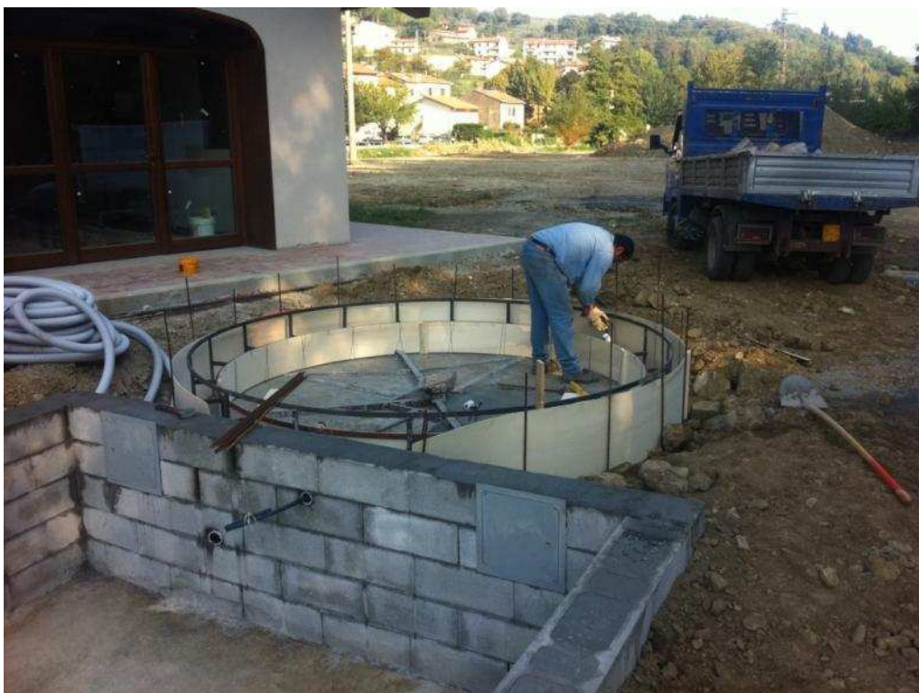
Figura 17 Montaggio dei pannelli per getto piattaforma
