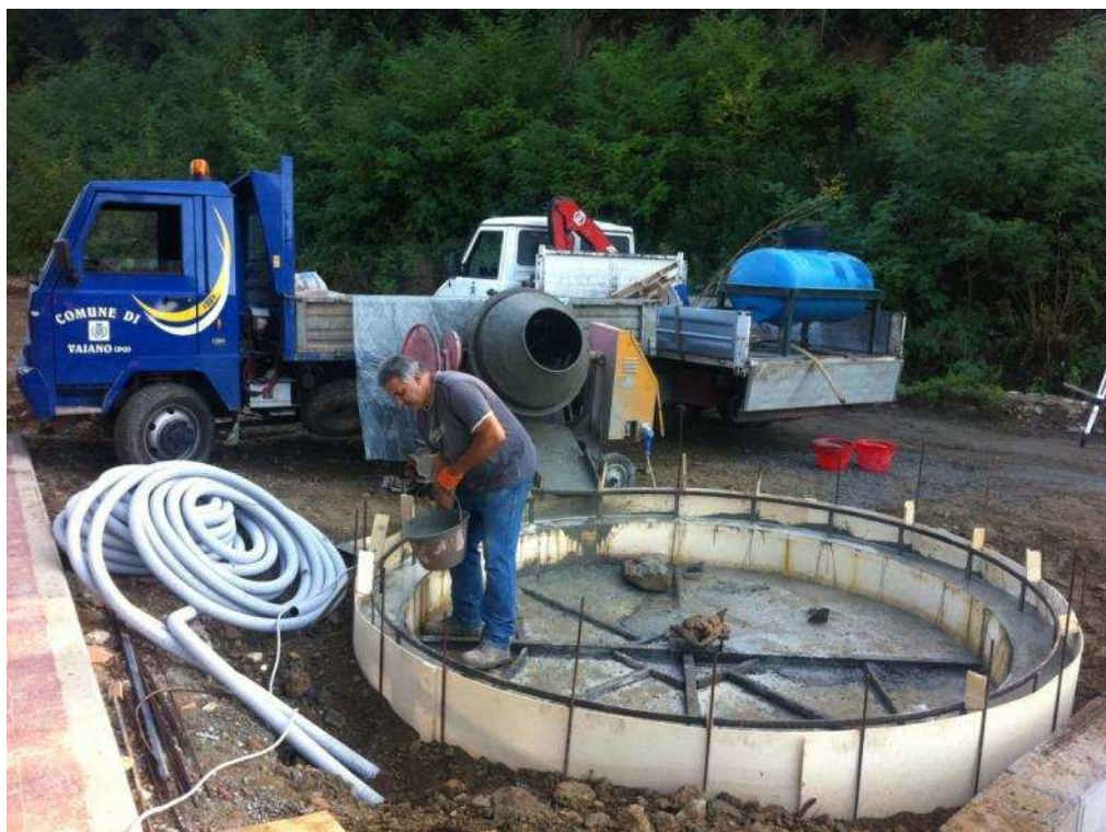
Figura 19 Getto del primo gradino
