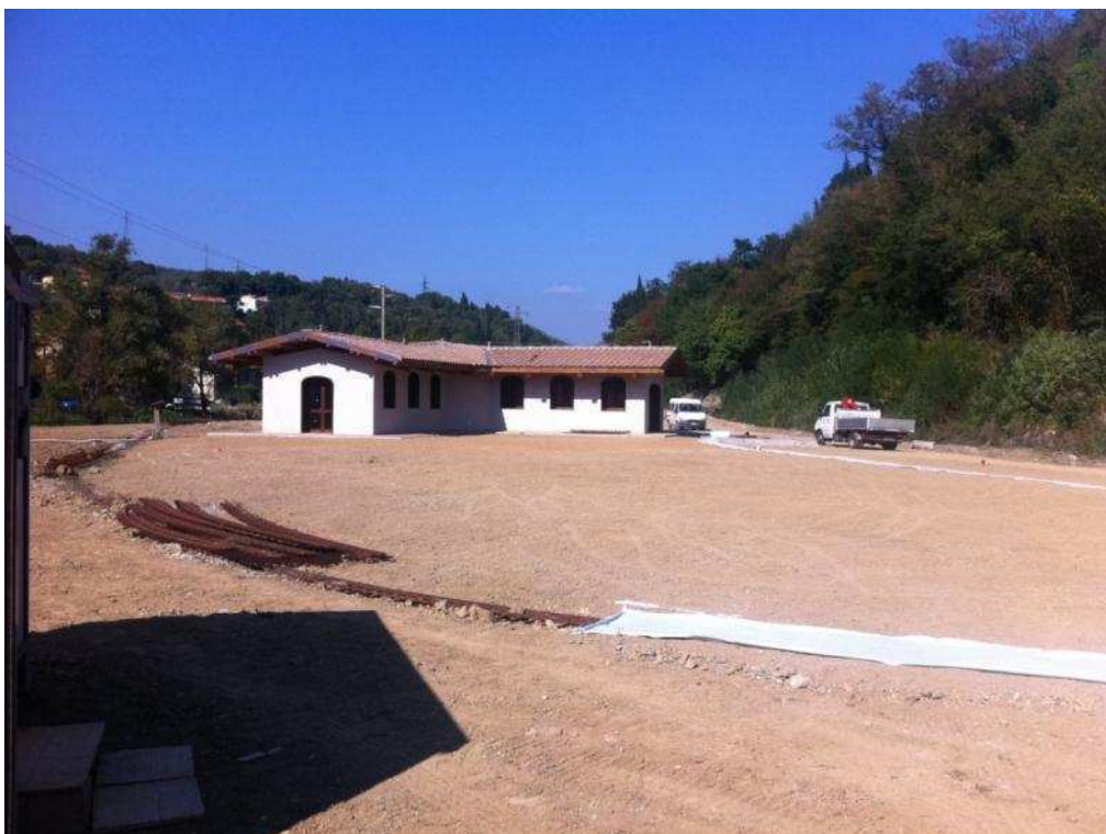
Figura 29 / 30 / 31 / 32 Tessuto non tessuto steso per la posa del 1° anello con collegamento al deposito
