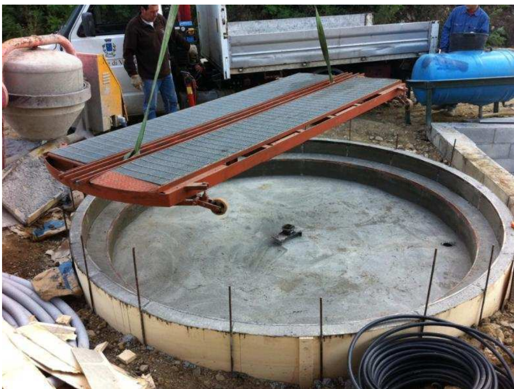
Figura 23 Inserimento della piattaforma
