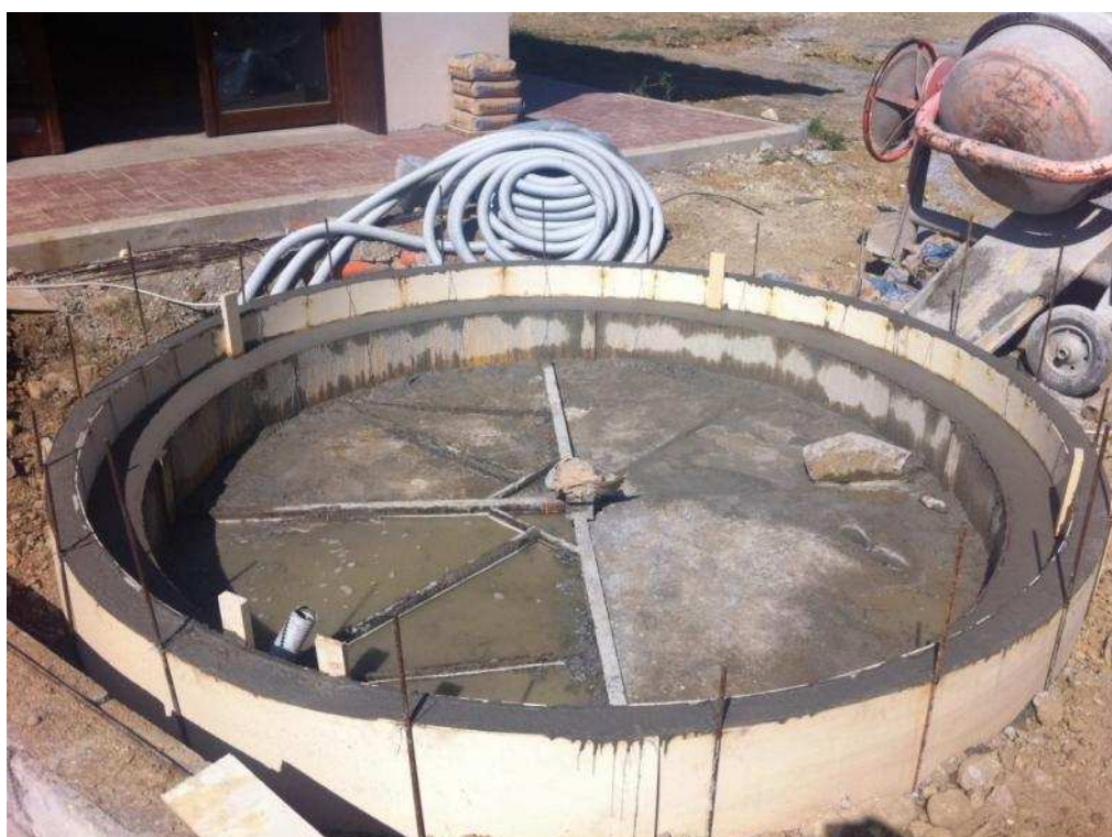
Figura 20 Piattaforma con i due gradini gettati
