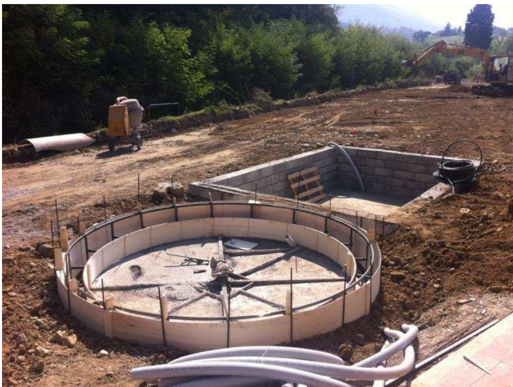
Figura 18 Armatura finita per gettare il primo gradino
