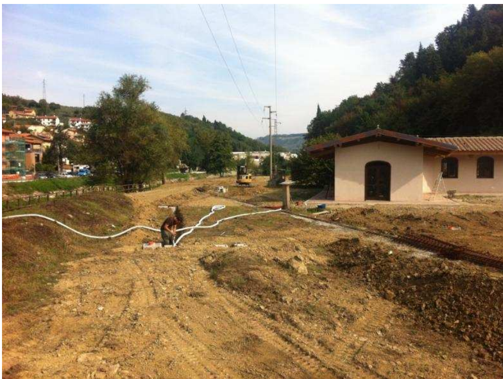
Figura 16 Elettricisti a posizionare gli ultimi corrugati per impianto di illuminazione
