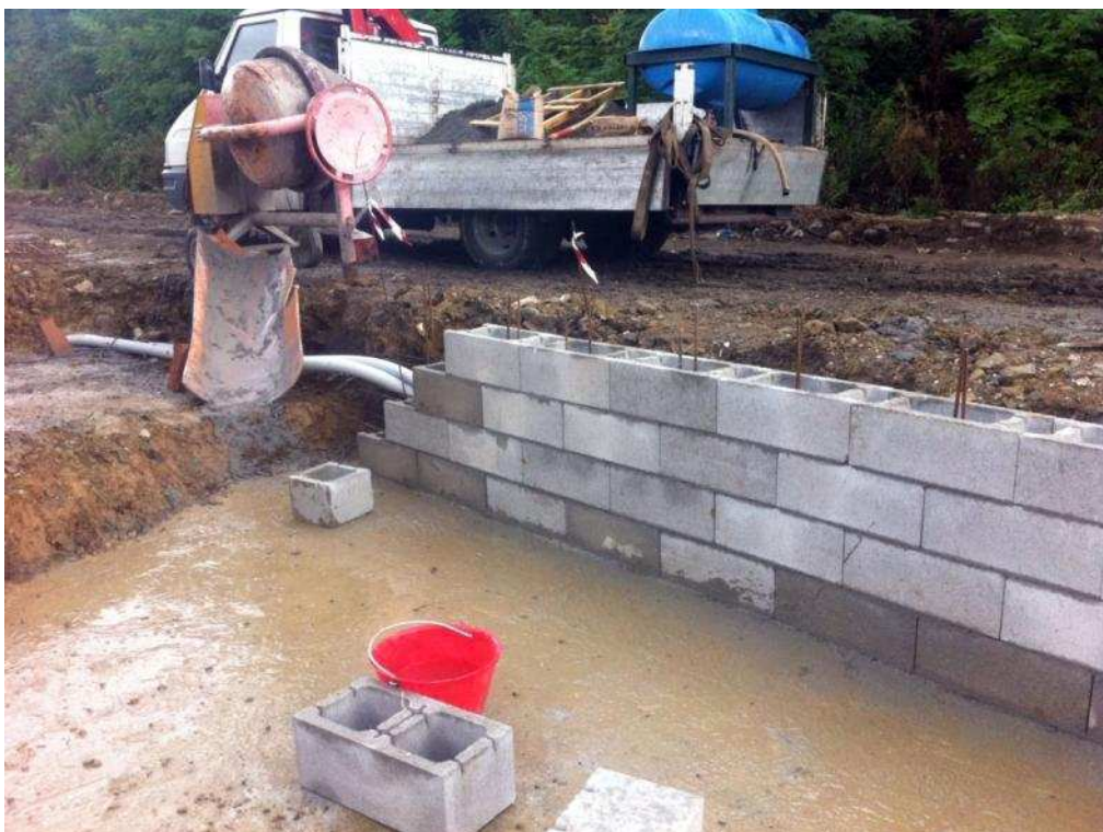
Figura 3 Muro da collegare al getto della piattaforma
