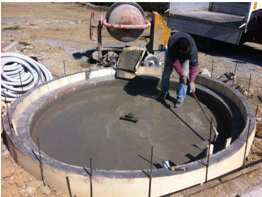
Figura 21 Livellamento della base
