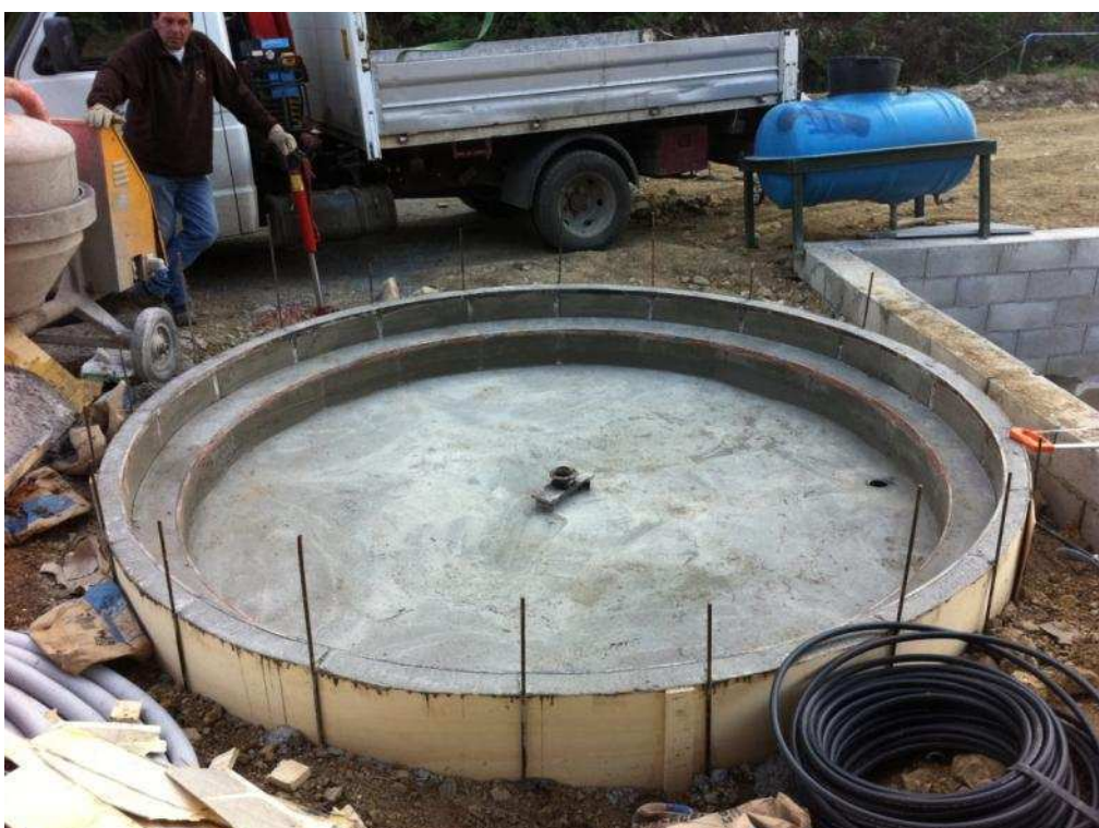
Figura 22 Piattaforma con i getti finiti
