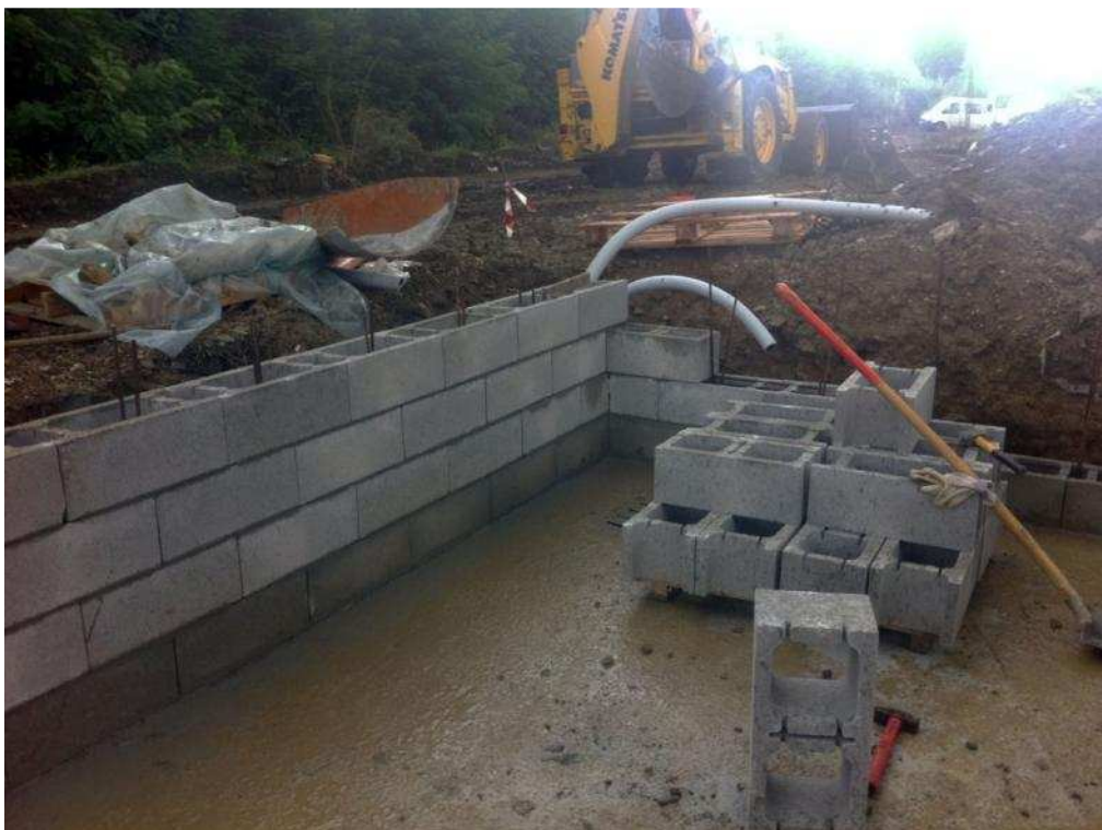
Figura 1 Inizio realizzazione muri di contenimento fossa esterna
