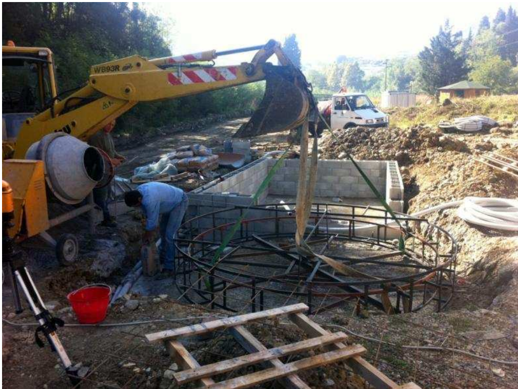
Figura 9 Livellamento della struttura
