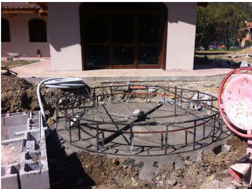
Figura 10 Getto della base di livellamento
