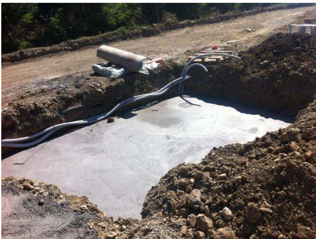
Figura 21 Getto finito in attesa di realizzare i muri perimetrali con casseri da getto
