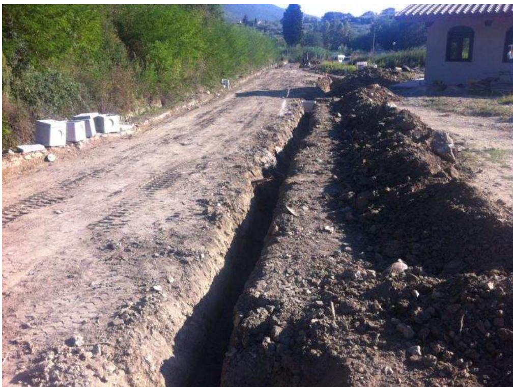
Figura 22 Scavi per posizionamento illuminazione parco e impianto di videosorveglianza
