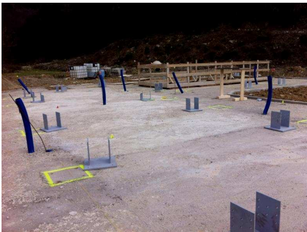
Figura 3 Posizionamento piastre per struttura in legno
