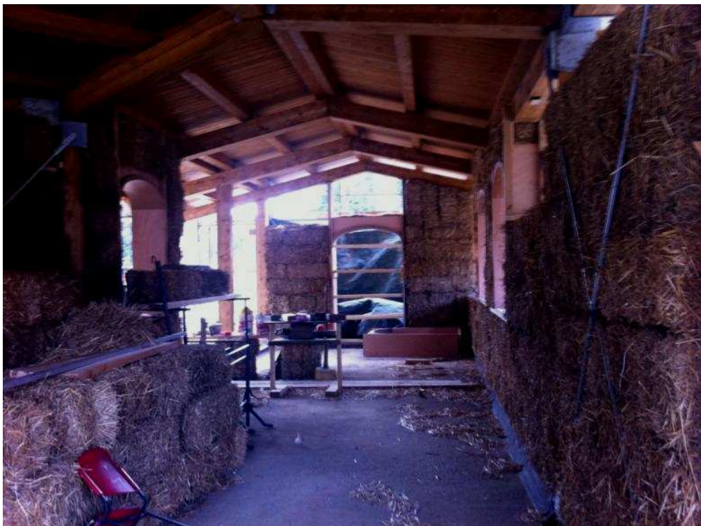
Figura 9 Posizionamento presse di paglia
