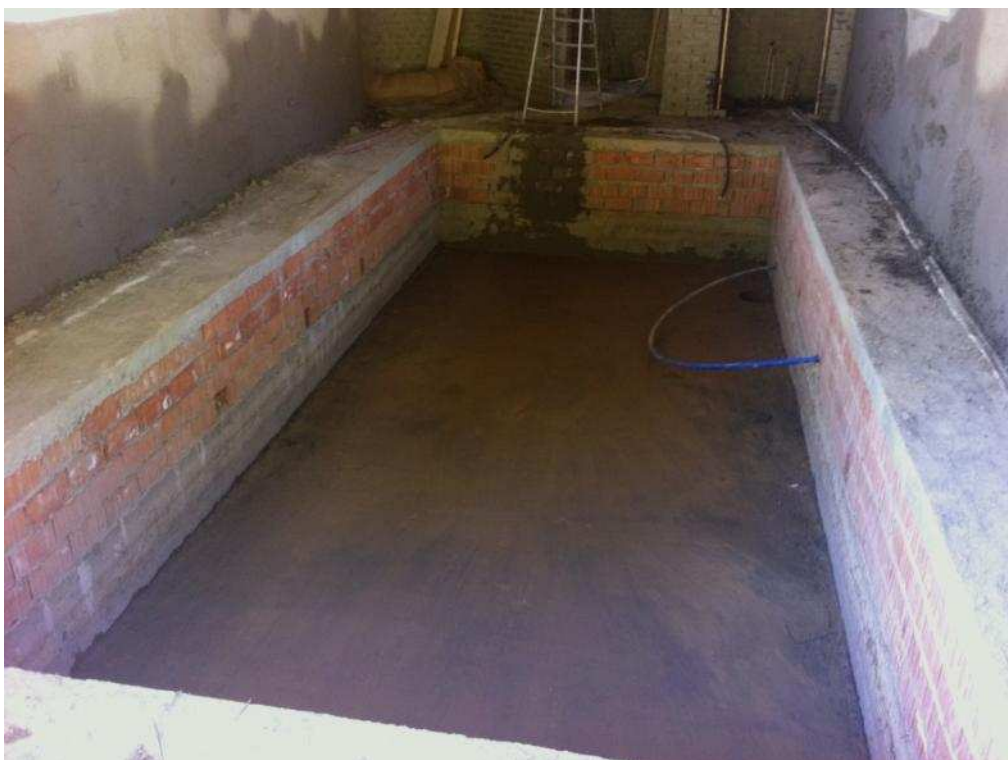
Figura 15 Vista dell'interno del fabbricato con la fossa di manutenzione treni
