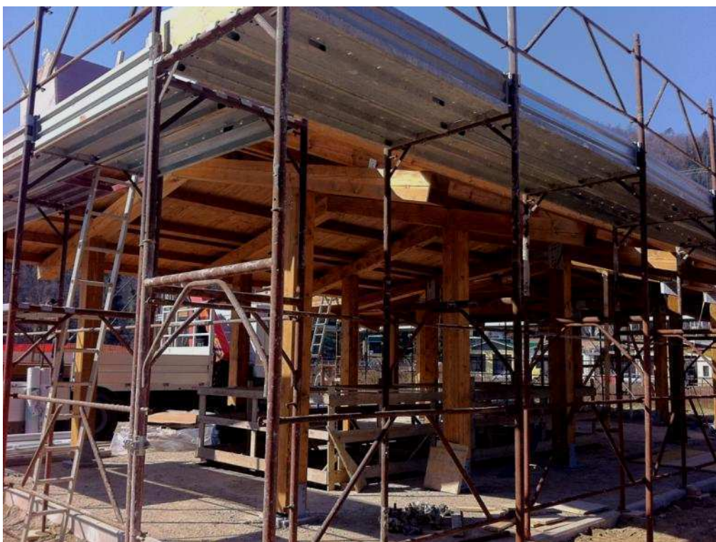
Figura 7 Ponteggio per copertura tetto in tegole
