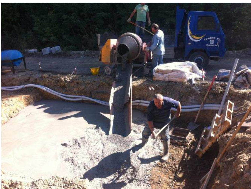
Figura 20 Getto in fase di realizzazione
