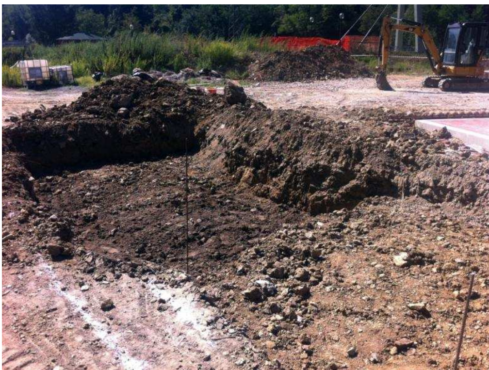
Figura 19 Scavo con ribassamento per binari esterni di manutenzione
