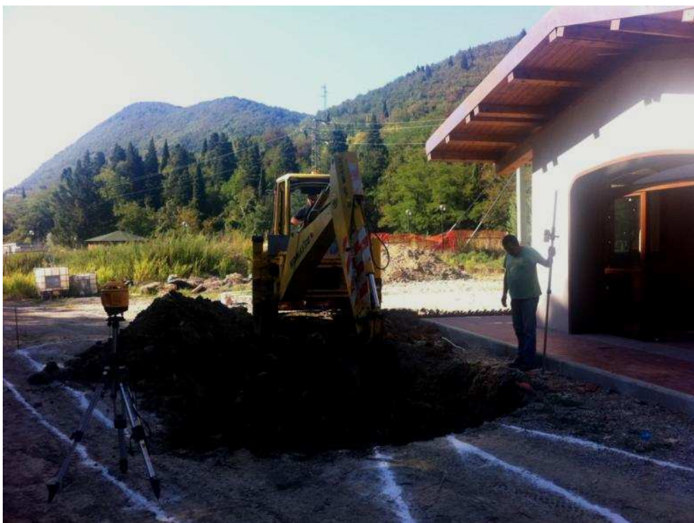
Figura 17 Inizio scavo per piattaforma e fossa esterna per i binari di manutenzione treni
